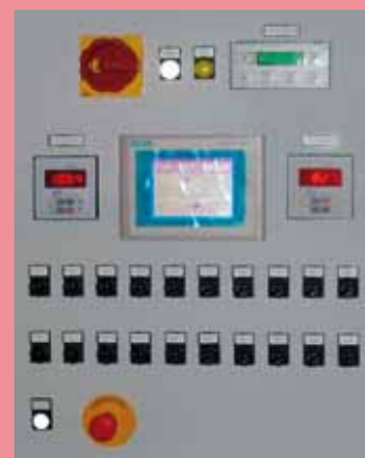
Quadro con PLC
