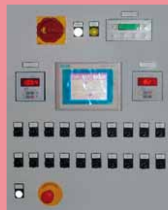
Quadro con PLC
